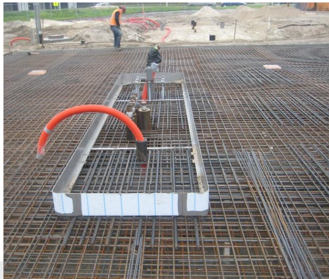
Foto: Voorbeeld in te storten onderdelen/wapening.
